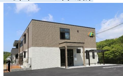
神戸須磨ケアセンターそよ風<外観>
